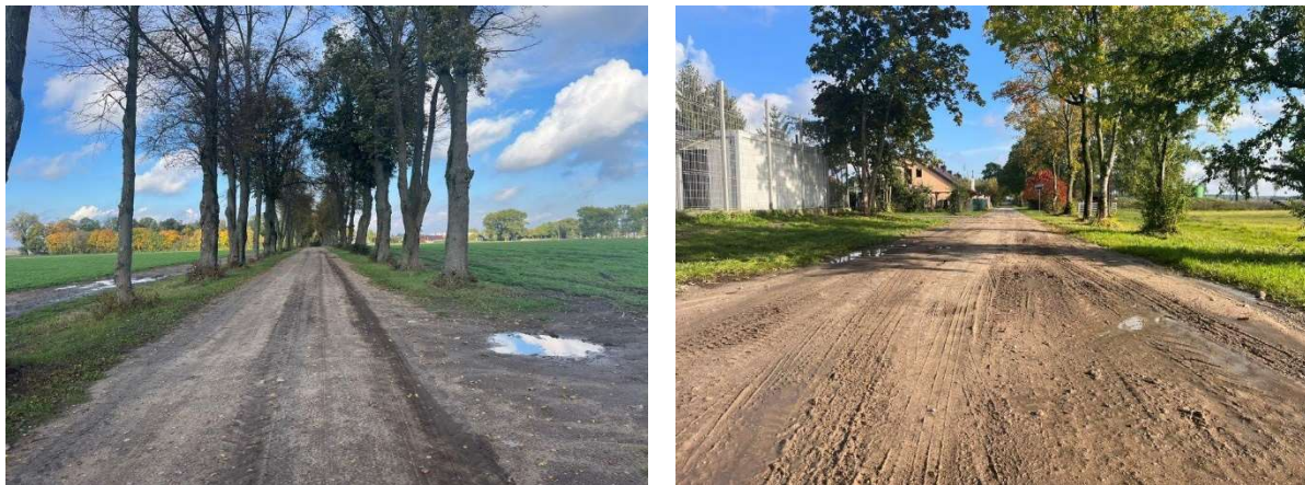
Rysunek 2. Stan techniczny drogi przebiegającej przez jednostkę Troski
